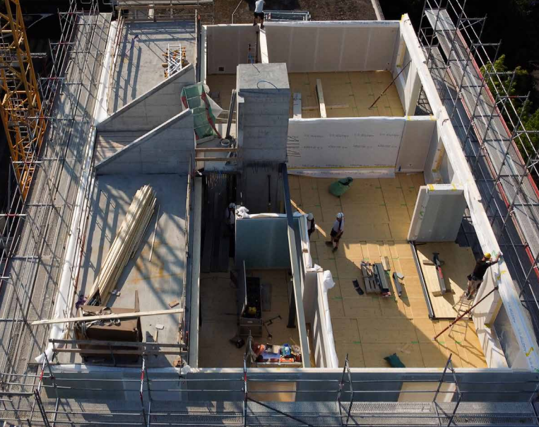
Aufstockung an der Rue de Beaumont in Genf
