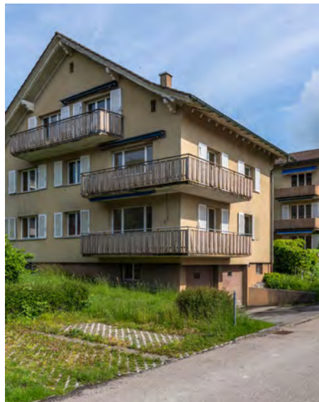
Cham, Nelkenweg 1, 3, 5 und Mattenstrasse 17
